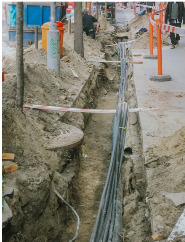
13. fotó: Közös közműárkos közművesítés
