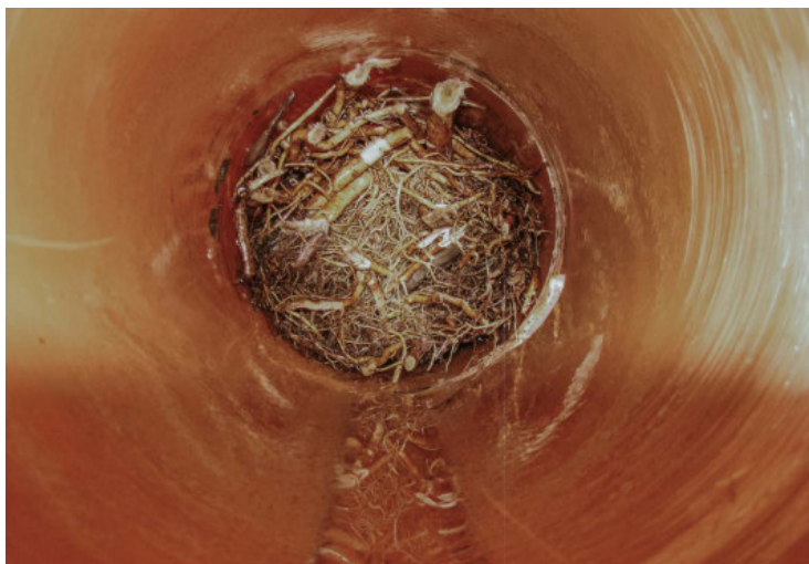
24. fotó: Gyökérbénítés a csatornában
