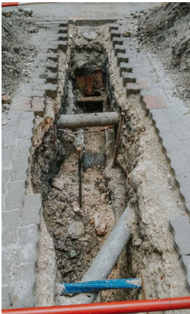
25. fotó: Gázvezeték rekonstrukció, Visegrádi utca, Budapest
