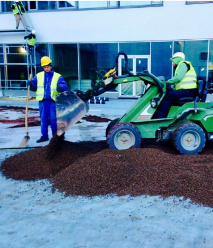
35. kép Ültetőközeg terítése szűrő geotextil felett fordított rétegrendű garázsfordőmen. Fotó: Dezsényi Péter
