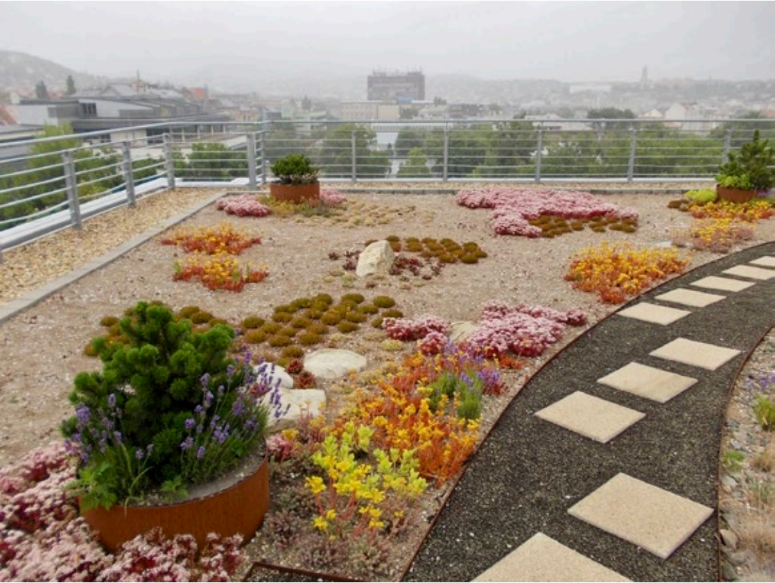
46. kép Frissen telepített biodiverz zöldtető egyedileg tervezett és helyszínen kevert extenzív ültetőközzel. Fotó: Dezsényi Péter
