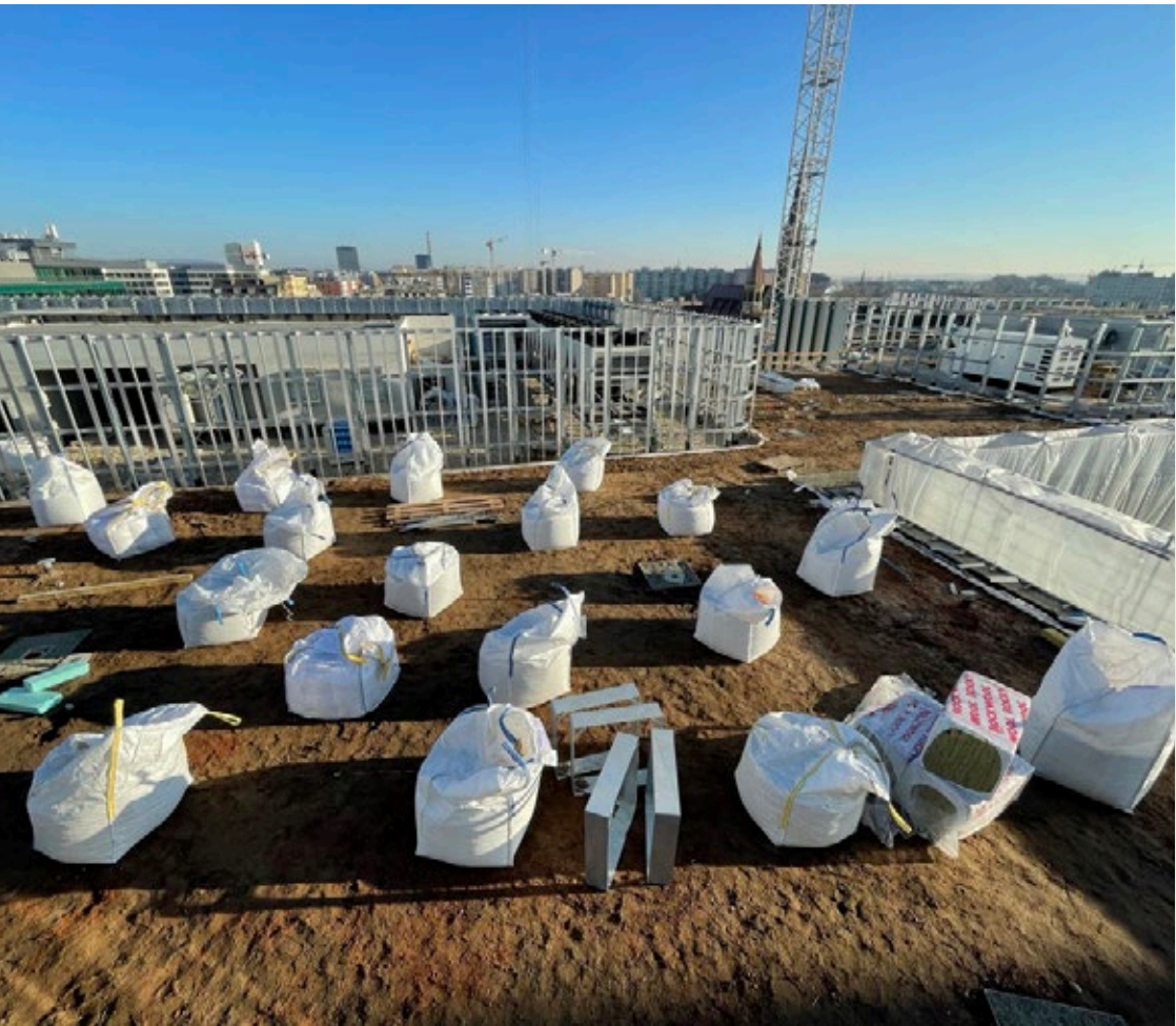
108. kép Helyes anyagtárolás a tetőn. Az építési műveletek födémterhelését méretezni és engedélyeztetni kell. Fotó: Dezsényi Péter
