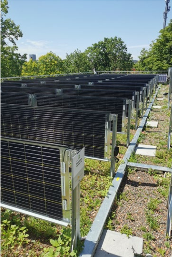
82. kép Kelet-nyugati tájolású, kétoldalú vertikális PV panelek egy winterthur-i nyomdaüzem bioszolár zöldtetőjén Svájcban. Fotó: Elisabeth Weiss-Tessbach
