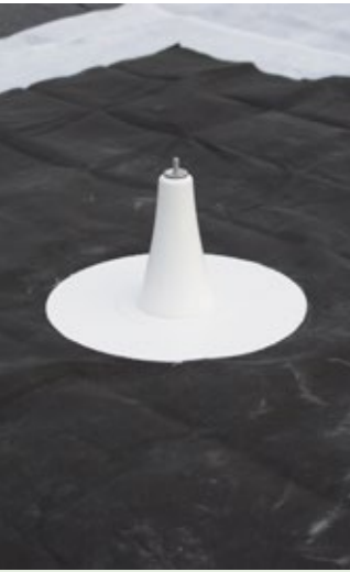
26. kép Zöldtetőn használatos kikötési pont. A műszaki geotextilre terített ültetőközeg biztosítja a megfelelő ellensúlyt. Fotó: Csabina Péter
