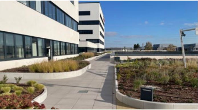
36. kép Vízáteresztő teraszburkolat zöldtetőn. Fotó: Dezsényi Péter
