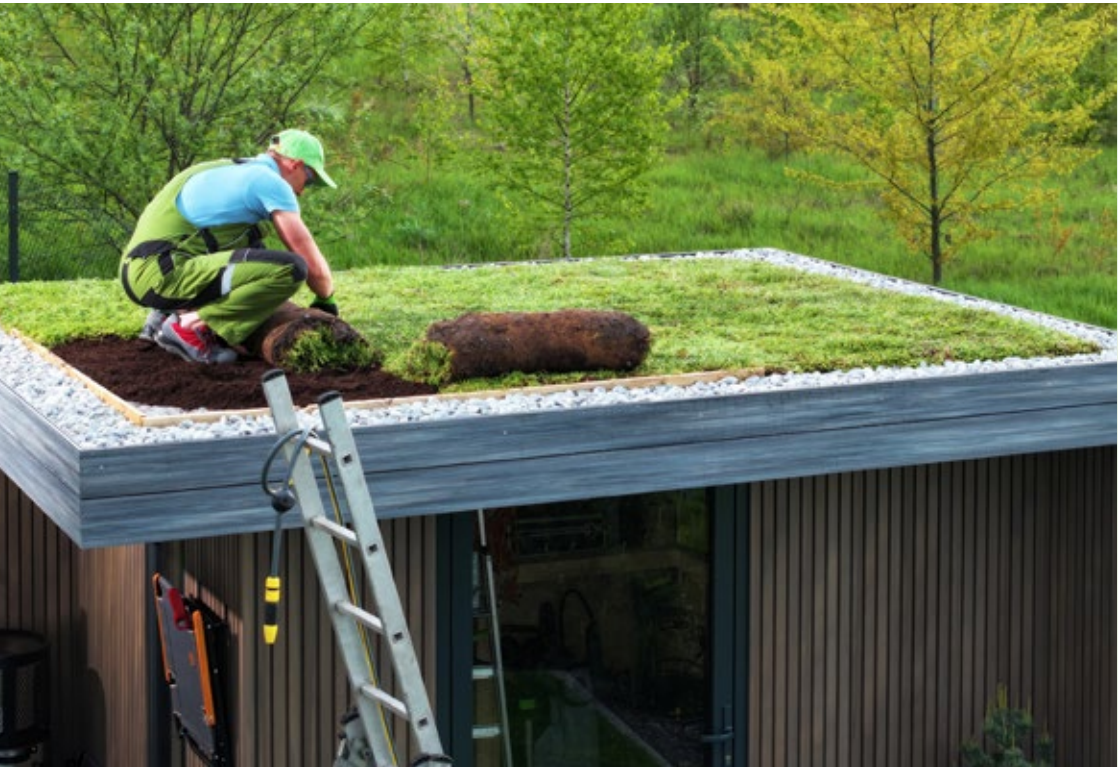
60. kép Varjúháj szőnyeg fektetése. Fotó: Hegymegi Artúr
