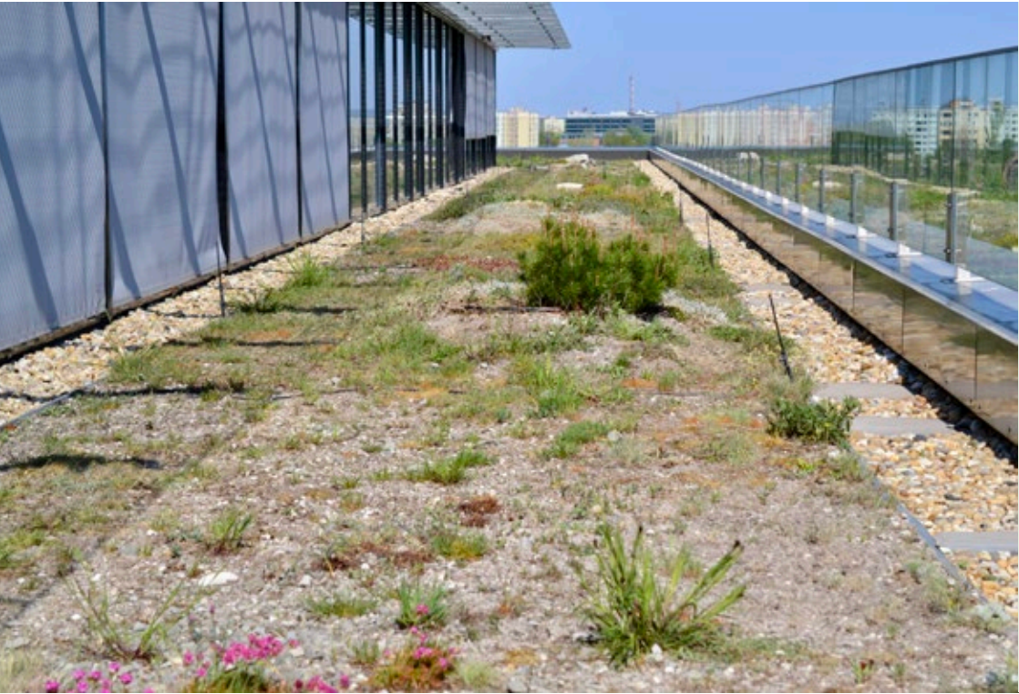
24. kép Biodiverz zöldtető növénytelepítés után. A széleken futó szivárgó kavicssáv a szélszívás ellen is véd. Fotó: Dezsényi Péter
