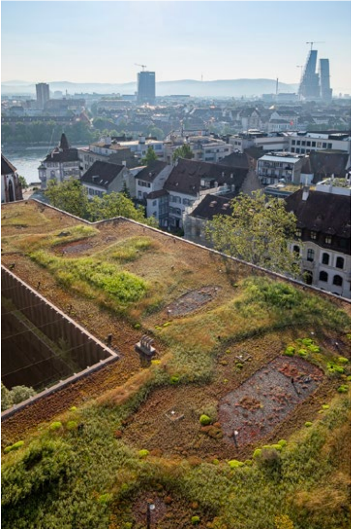
68-69. kép Mikrodomborzat és heterogén ültetőközeg használat egy svájci kórház biodiverz zöldtetőjén növénytelepítés előtt és után. Fotó: Stefan Brenneisen
