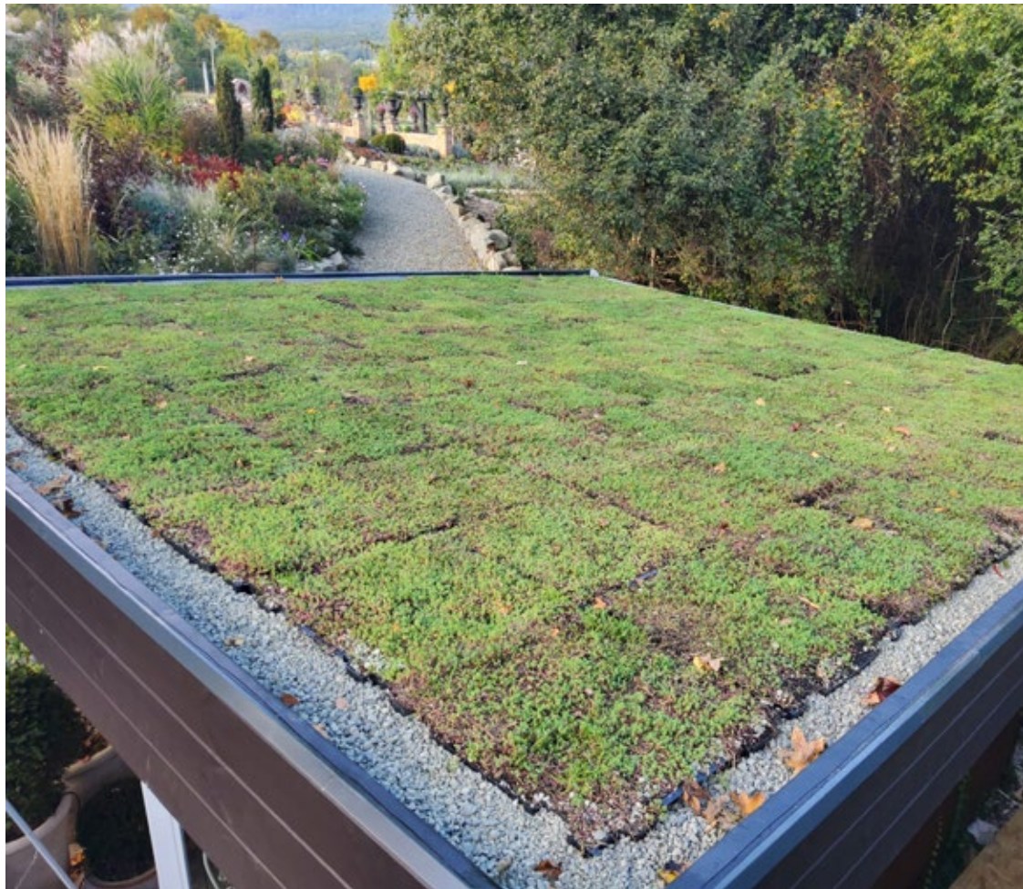
97. kép Moduláris zöldtetőrendszerből felépített extenzív zöldtető. Fotó: Hegymegi Artúr
