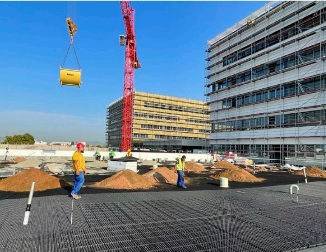
32. kép Mechanikai védőréteg, műanyag drénlemez és szűrőréteg kivitelezés közben egyenes rétegrendű zöldtetőn. A három műszaki réteget lerakás után rögtön le kell súlyozni. Fotó: Dezsényi Péter
