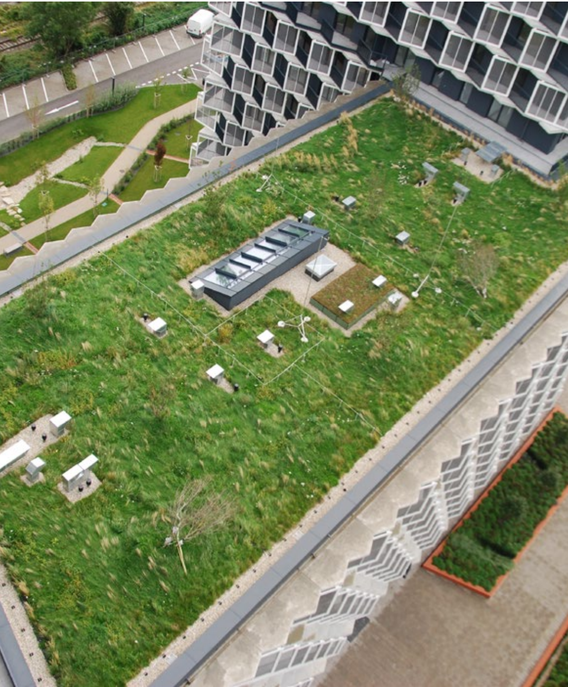
34. kép Pozsonyi zöldtető felülnézetből. Jól kivehető a függőleges kavicsszivárgó a zöldtetőn szélein és a tetőn található felépítmények és műszaki elemek körül. Fotó: Elisabeth Weiss-Tessbach
