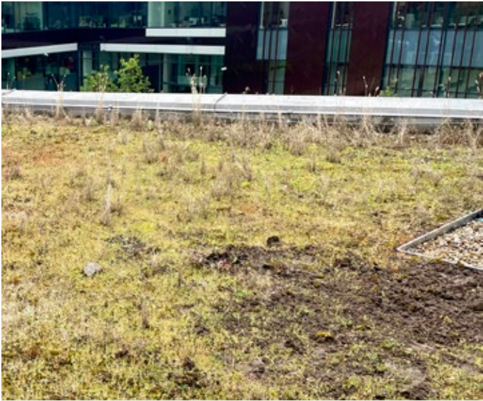
49. kép Jó minőségű ültetőközeg helyett termőföldet használtak ezen az extenzív zöldtetőn. Néhány évvel az átadás után már csak egy- és kétszikű gyomok borítják. Fotó: Dezsényi Péter
