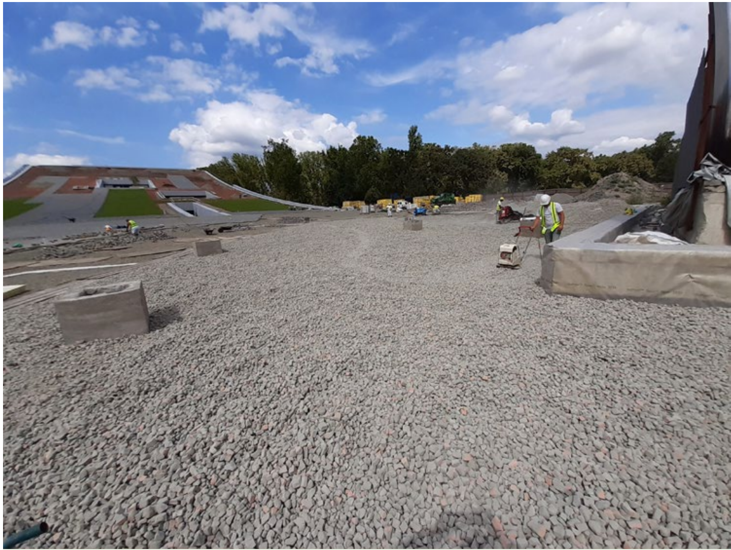
101. kép Üveghab granulátum terítése és tömörítése az Új Néprajzi Múzeum pincszintjének földémszerkezetén. Fotó: D. Nagy Balázs
