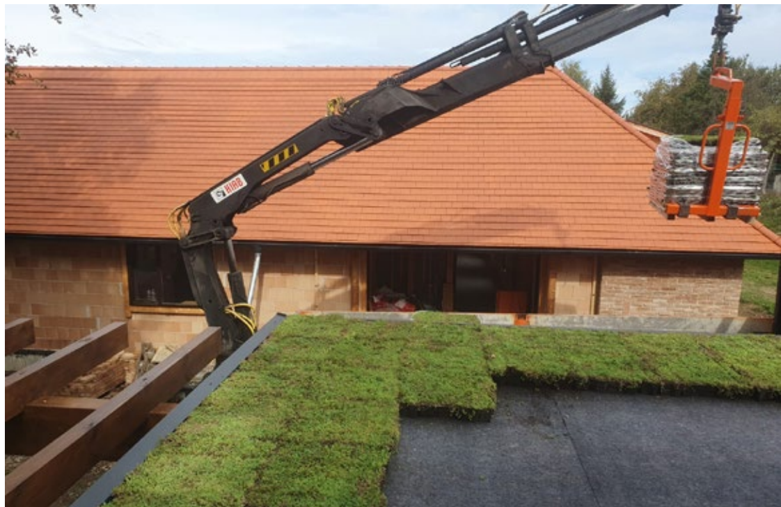
98. kép Moduláris zöldtető rendszer daruzása. Csak mechanikai védőréteg kell a tálcák alá. Fotó: Hegymegi Artúr
