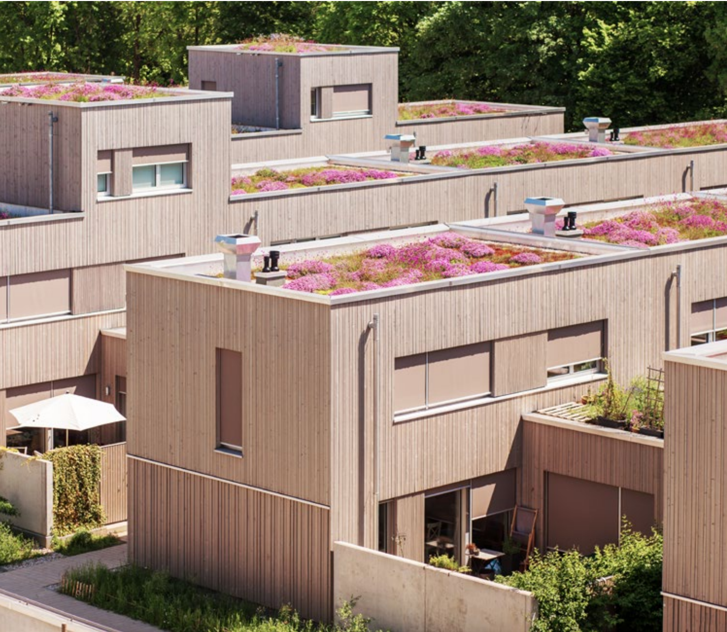
23. kép Extenzív zöldtetők egy német lakóépületen. Egy vékony rétegrendű extenzív zöldtető teljes kertészeti felépítménye vízzel telített állapotban 100-150 kg/m². Fotó: Mariana Serdynska
