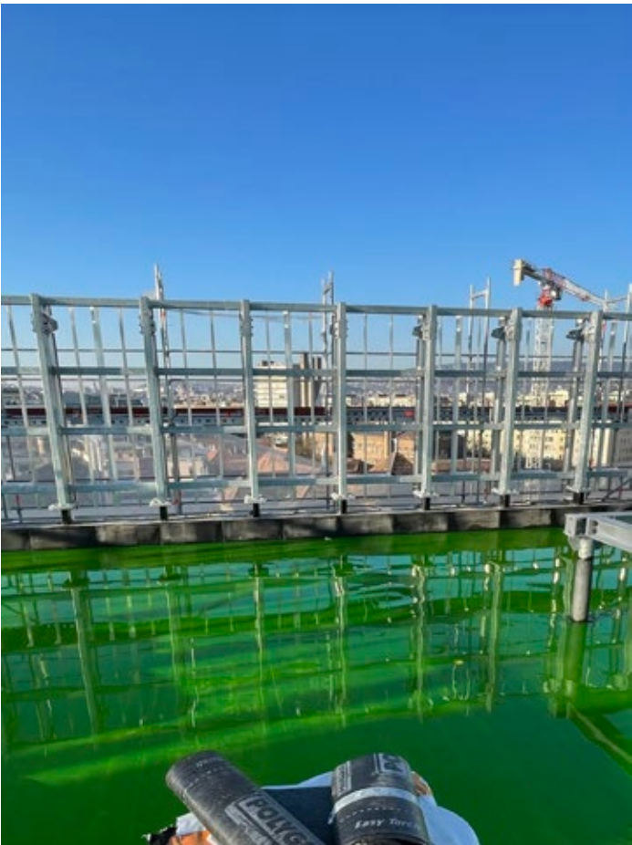
106. kép Árasztásos próba csapadékvíz-szigetelés átadása előtt. Fotó: Dezsényi Péter
