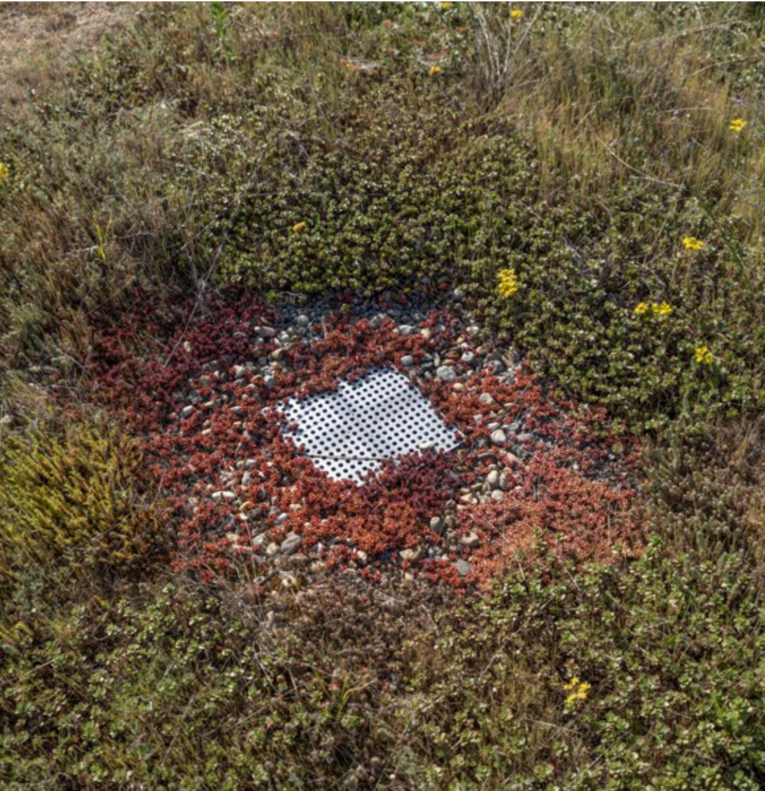
25. kép Tisztítóakna extenzív zöldtetőn kavicsszivárgóval körülvéve. Fotó: Dezsényi Péter
