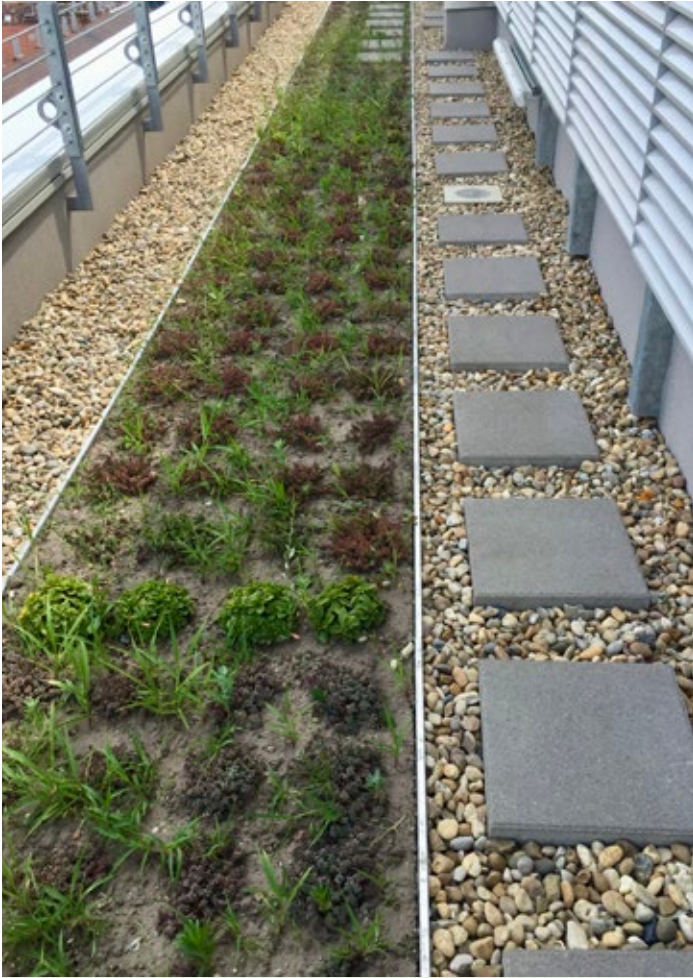
112. kép A frissen eltelepített varjúháj palántákat már a telepítés utáni hetekben kezdik ellepni a gyomok. A kivitelező nem ültetőközeget, hanem termőföldet használt – az eredetileg tervezett vegetáció egy-két év alatt teljesen eltűnik, ha nem a megfelelő ültetőközeget használjuk. Fotó: Dezsényi Péter
