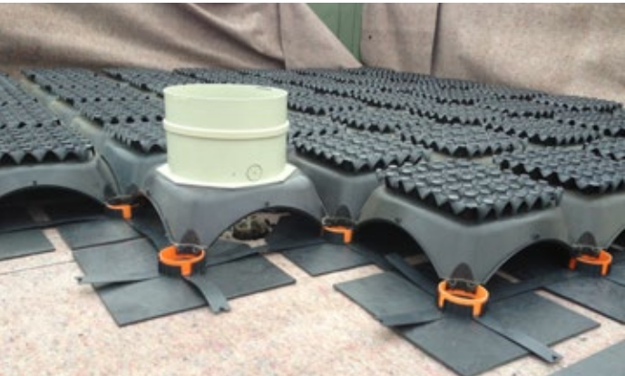
86. kép Moduláris tartórendszer vízárasztásos zöldtetőn. A lefolyócső nyaktag magassága menetes szárral állítható. Fotó: Diadem
