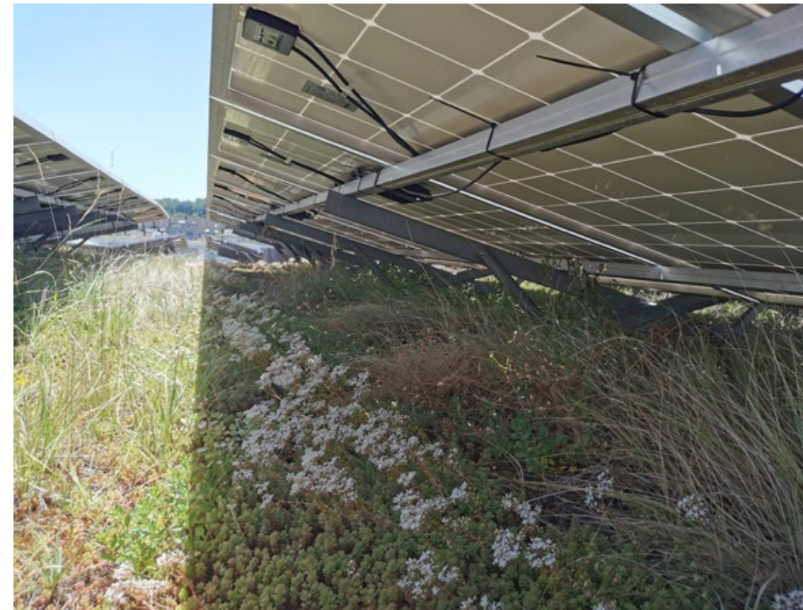
79. kép A napelemek árnyékolják a növényeket, így közvetve növelik a biodiverzitást és a biológiai aktivitást. A növények cserébe hűtik a levegőt, ezáltal nő a PV panelek hatékonysága. Fotó: Elisabeth Weiss-Tessbach
