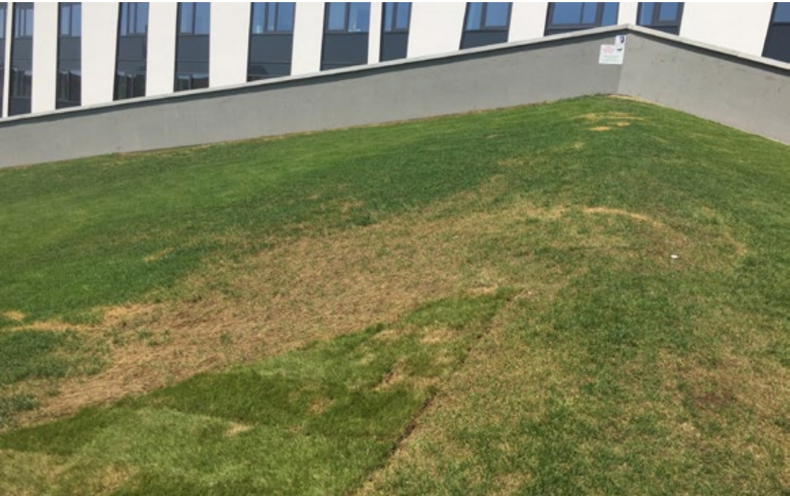
110. kép Nyári kép egy szélnek és napnak erősen kitett, lejtős intenzív zöldtető gypfelületéről. A felszíni szórófejes öntözés ebben az esetben önmagában nem elég hatékony a száraz és forró nyári hónapokban. Fotó: Dezsényi Péter
