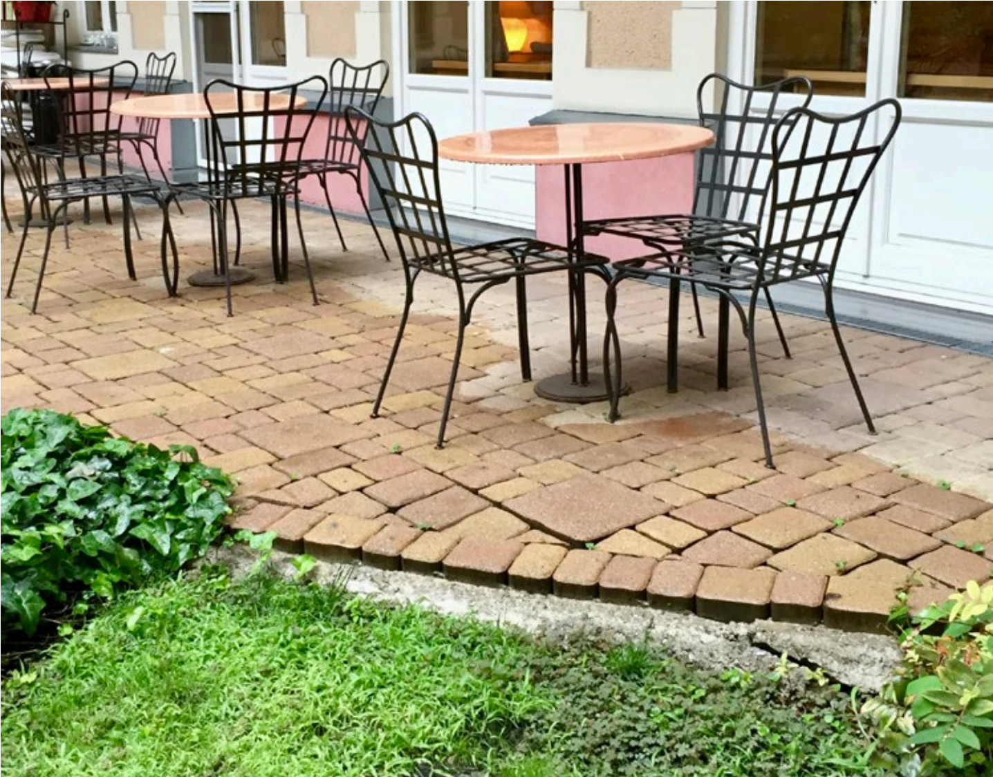
50. kép A zöldfelület szintje néhány év alatt jól láthatóan megsüllyedt, mivel az ültetőközegben használt tőzeg lebomlott. Fotó: Dezsényi Péter
