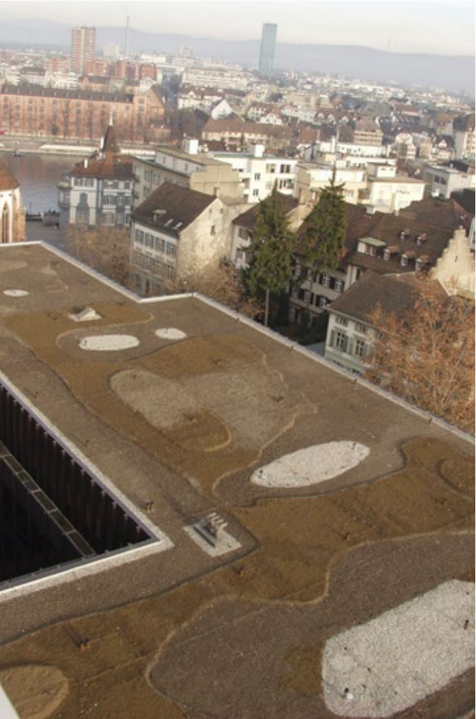
68-69. kép Mikrodomborzat és heterogén ültetőközeg használat egy svájci kórház biodiverz zöldtetőjén növénytelepítés előtt és után. Fotó: Stefan Brenneisen
