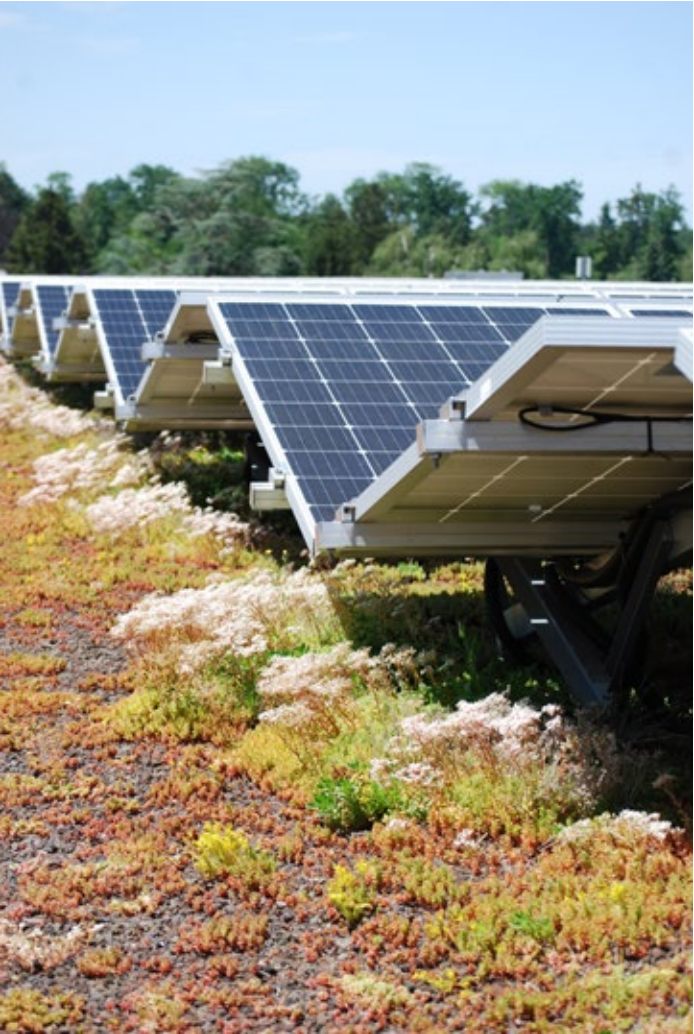
81. kép Bioszolár zöldtető Zürichben kelet-nyugati tájolású PV panelekkel. Fotó: Elisabeth Weiss-Tessbach
