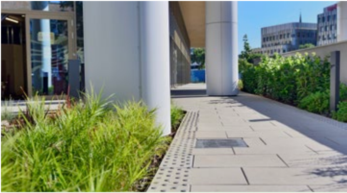
37. kép Zártfűgás, hagyományos térkő burkolat intenzív zöldtetőn. Fotó: Glázer Attila
