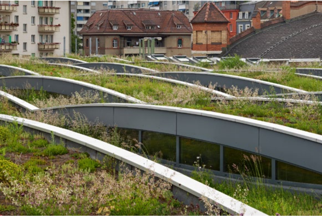
100. kép A bázeli villamos remíz épületének faszerkezetű tetőjén létesített extrém könnyű zöldtető képe. Fotó: Stefan Brenneisen
