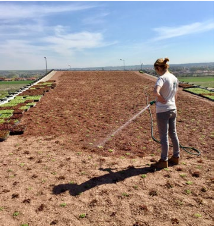
61. kép Frissen telepített sedum palánták beöntözése. A telepítés utáni első nyáron hetente két-három alkalommal alapos beöntözés szükséges a növényállomány sikeres záródásához. Fotó: Dezsényi Péter
