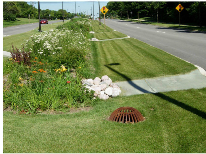
48. fotó Szűrőárok túlfolyóval, USA
