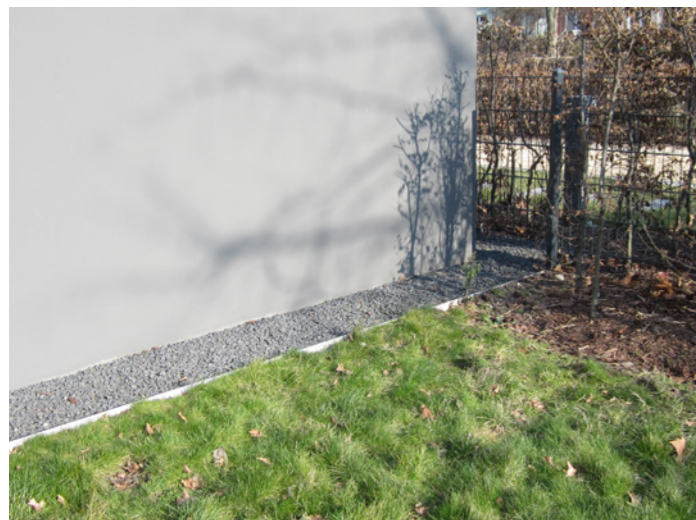
19. fotó Épület melletti drénárok andezit zúzalékkal
