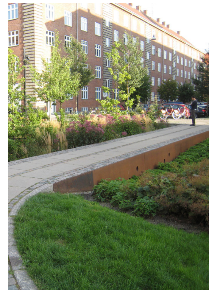
53. fotó A támfalban lévő átereszekon keresztül a víz a második kazettába juthat
