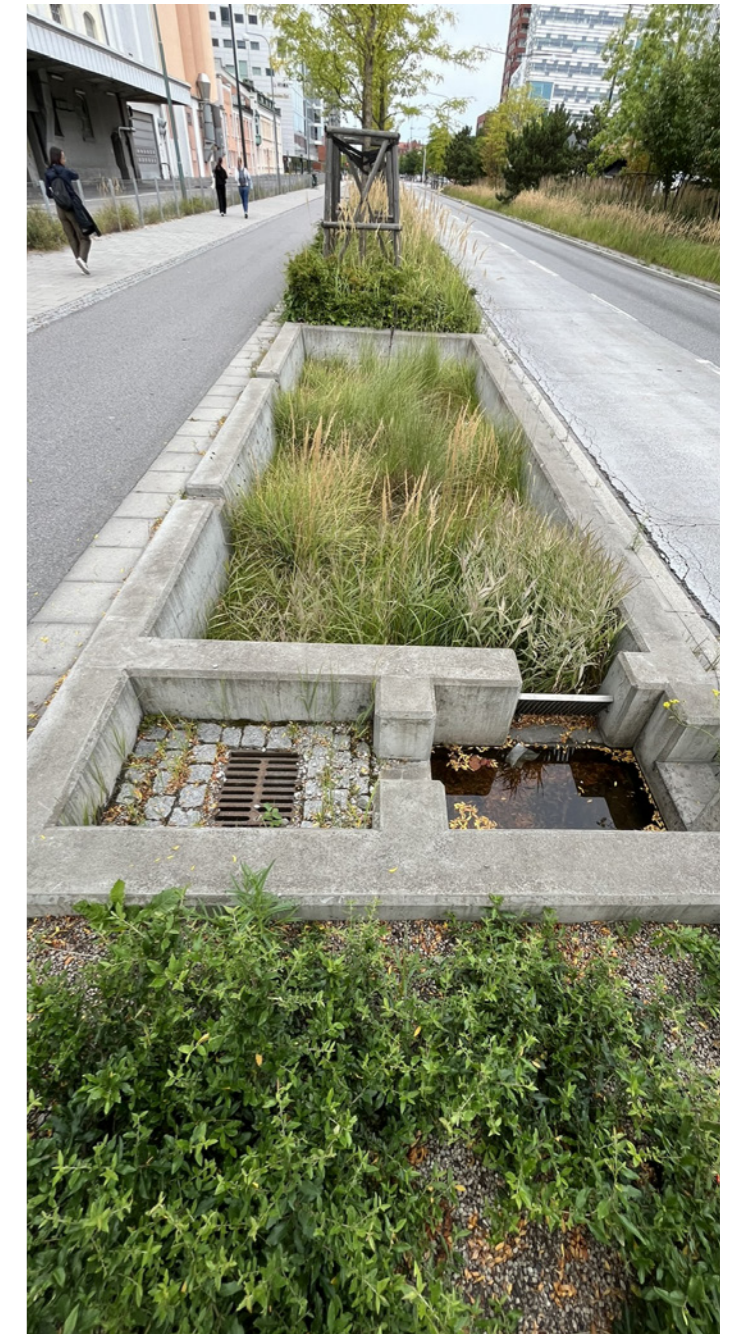
18. fotó Áttört szegély vezeti az esőkerbe a csapadékvizet a burkolatról, Malmö
