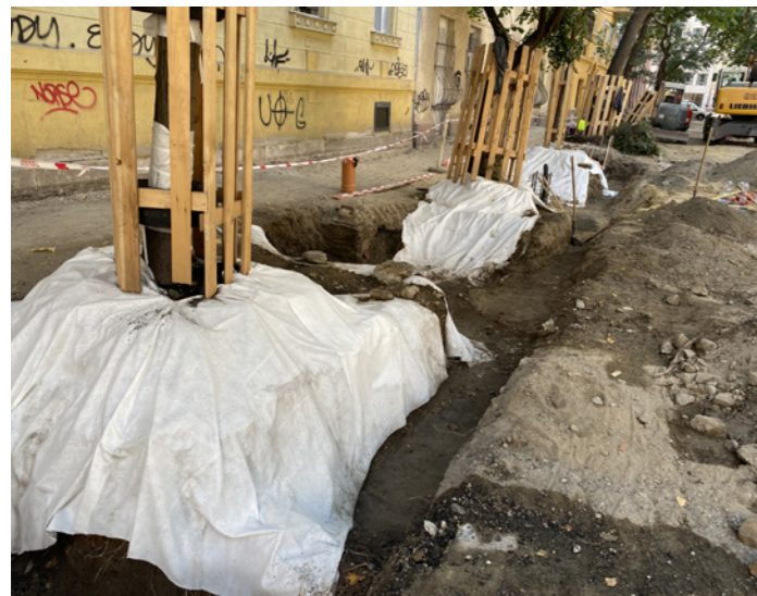
72. fotó Bakáts utca: feltárást követően a fák gyökereit takarni és nedvesíteni kell
