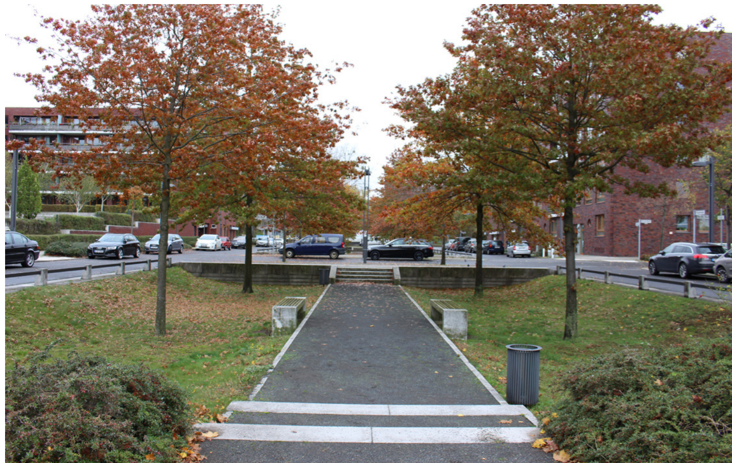
67. fotó Az utak esővizét gyűjtő süllyesztett zöldfelület, mely kisebb eső idején szikkasztóárokként, felhőszakadás esetén ideiglenes víztározóként működik.
