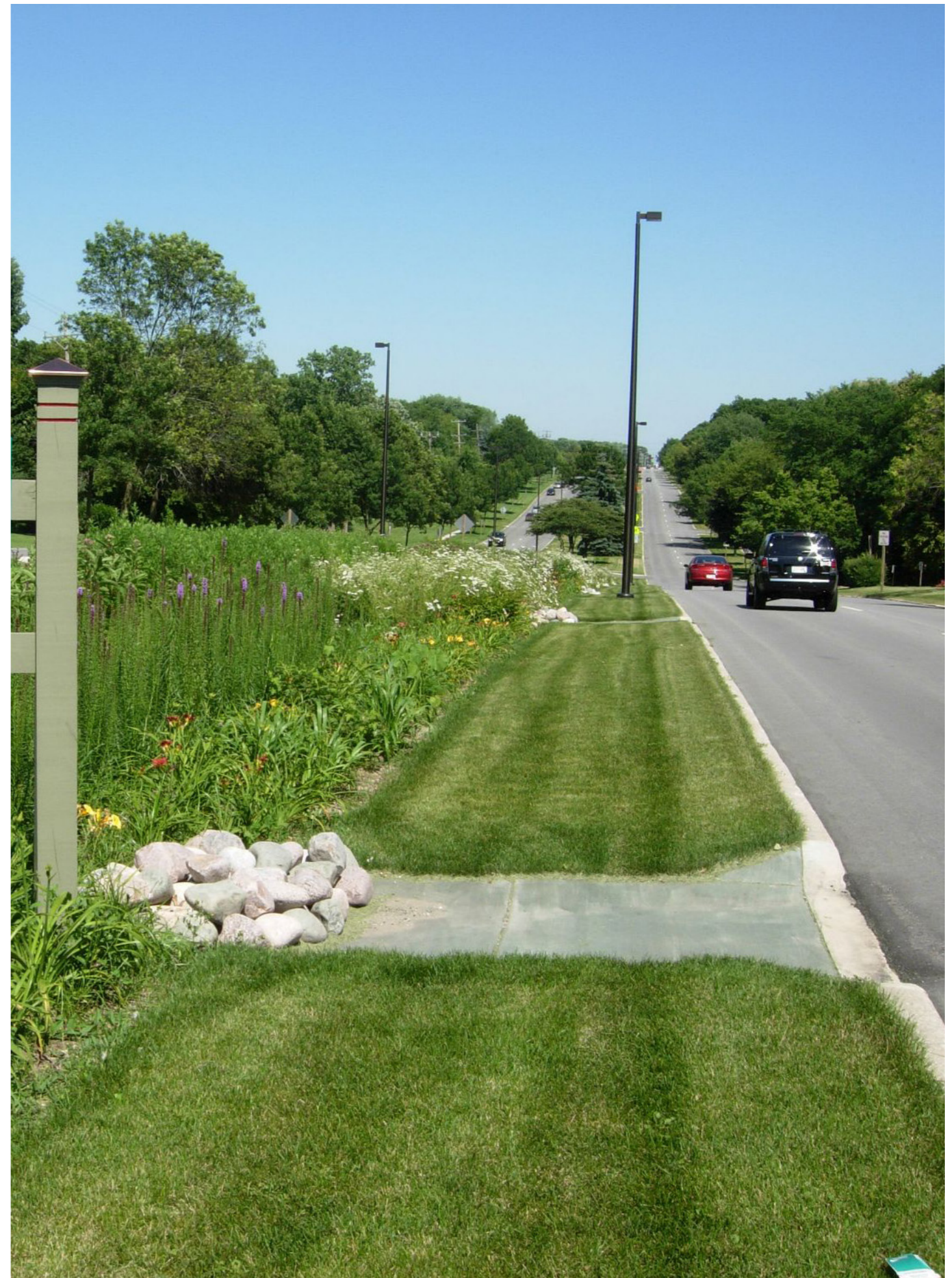
49. fotó Alacsony forgalmú autótút csapadékvíz tisztító szűrőárok, Egyesült Államok
