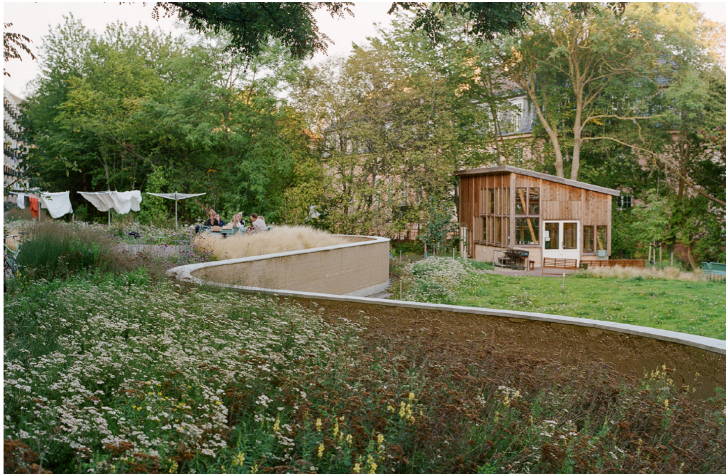
57. fotó Döngölt vályogfal választja el a kert vízgyűjtő területeit az épülettől
