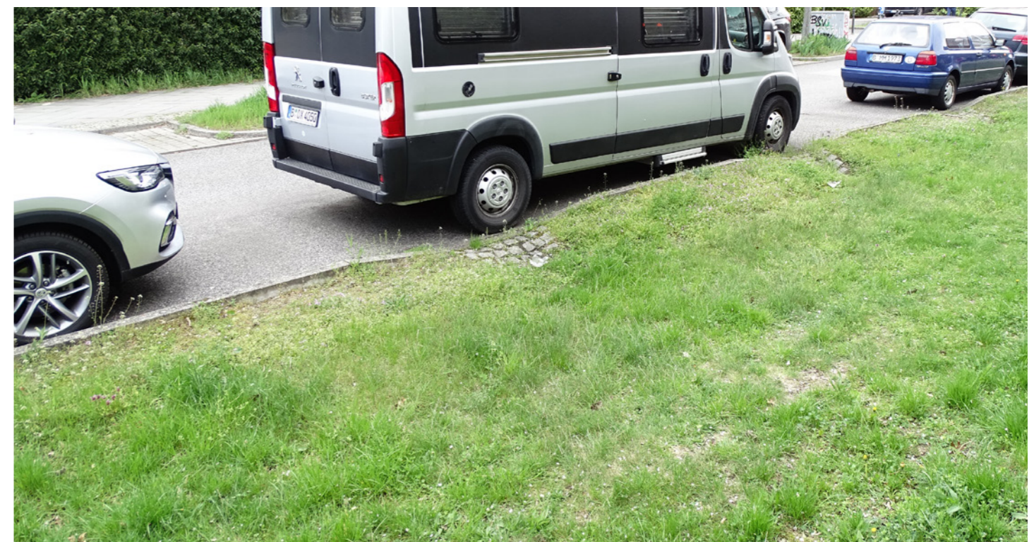
64. fotó Áttört szegély vezeti a csapadékvizet az útburkolatról a gyepes szikkasztóárkokba
