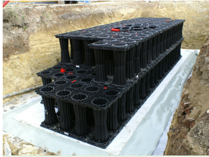
40. fotó Szikkasztóládás csapadékvíz szikkasztás
