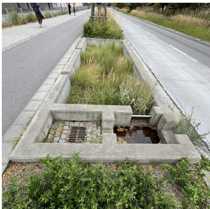
37. fotó Esőkert Malmöben túlfolyóval és tisztító műtárggyal
