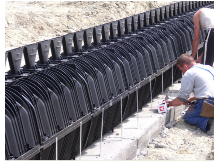
42. fotó Nagy tározókapacitású részfolyóka beépítése
