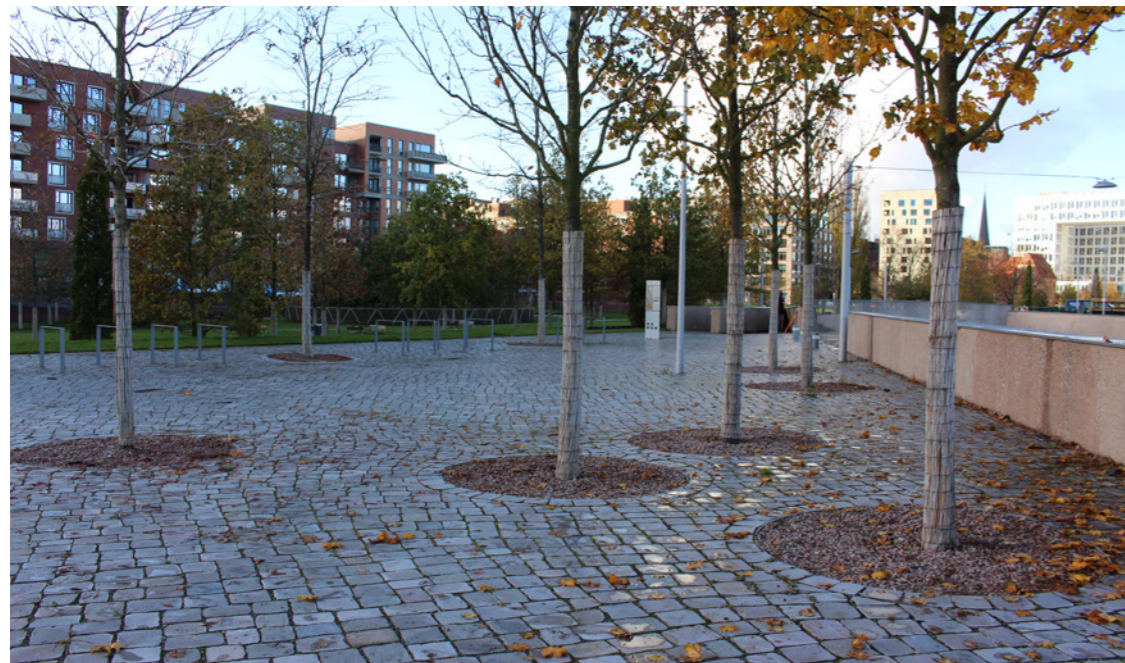
14. fotó A kiselemes terméskő burkolat átveszt a vizet a fák gyökeréhez, Lohsepark, Hamburg
