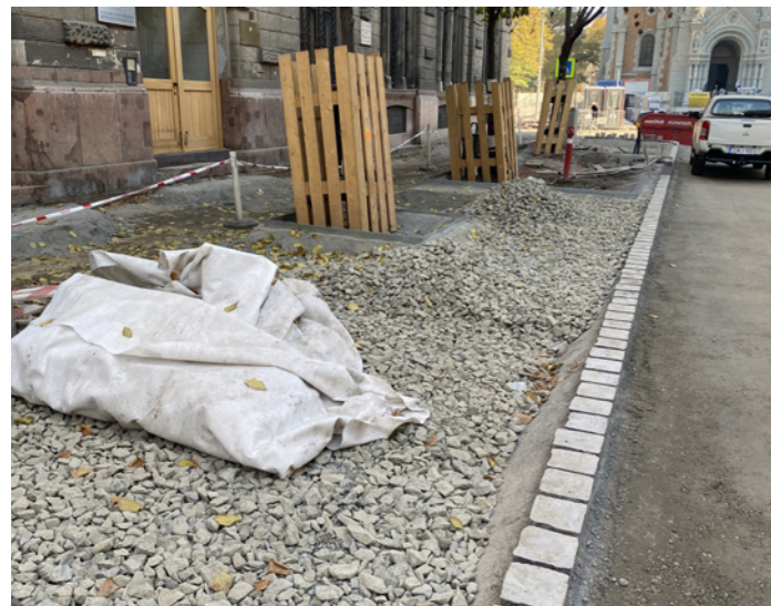
73. fotó Bakáts utca: 60 cm SFR szerkezeti talajjal és 20 cm drain réteggel visszatöltött gyökérzóna, amely már tömöríthető, stabil alépitmény a járda és az úttest számára
