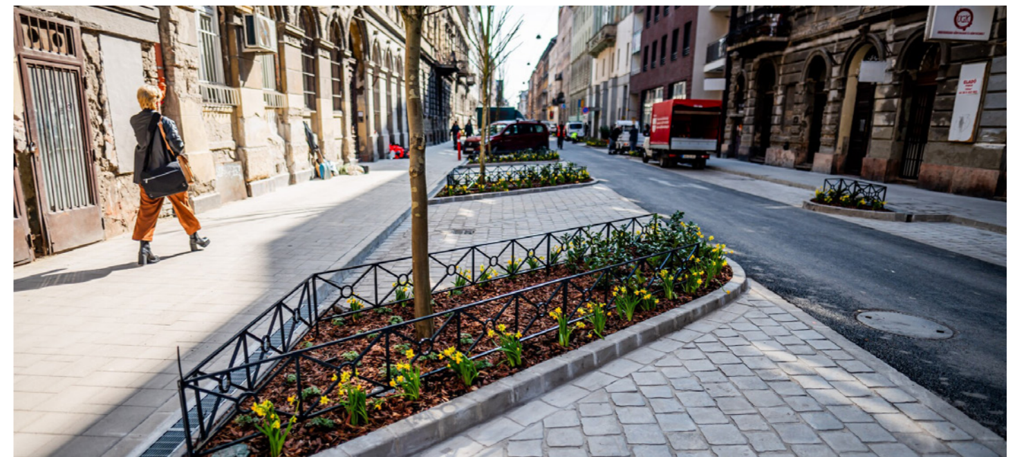
77. fotó SFR módszerrel telepített platán fasor, ahova a tetőkről lefolyó csapadékvizek bevezetésre kerülnek
