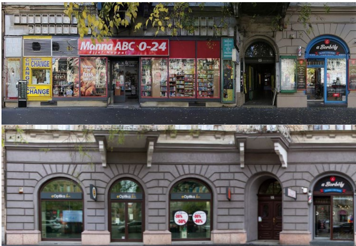
Teréz körút 50. a homlokzat átépítése előtt és után
