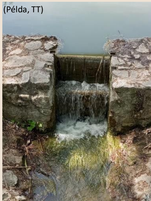
„B” változat: habarcsba rakott terméskő burkolat fapallókkal
