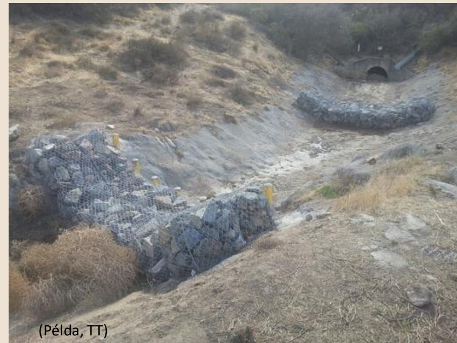
„C” változat: gát építése gabionból
