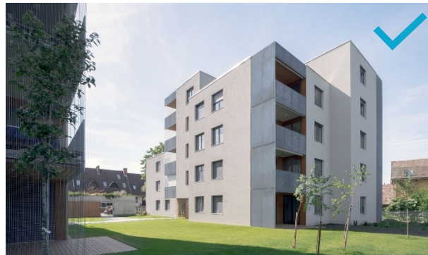
Változatos épületmagasság tömbön belül, megfelelő benapozottság. Kőér utca, Budapest https://www.archdaily.com/
