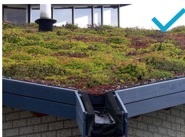
„Ultrakönnnyű” extenzív zöldtető (50-70 kg/m 2 ) ( https://zoldtetok.hu/ultrakonnnyu-extenziv-zoldteto/ )
