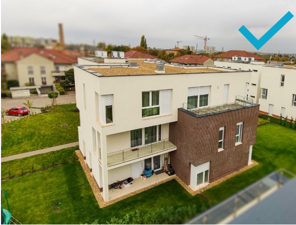
Gergely Garden lakópark, Budapest X. kerület – geotermikus fűtési/hűtési rendszerrel kialakított, lazán elhelyezett lakóépületek ( https://mbingatlan.hu/ )
