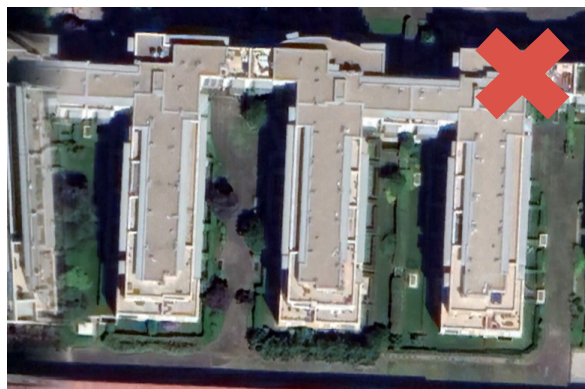
Lakóépület kedvezőtlen légtérarányú, három oldalról zárt udvarterei
