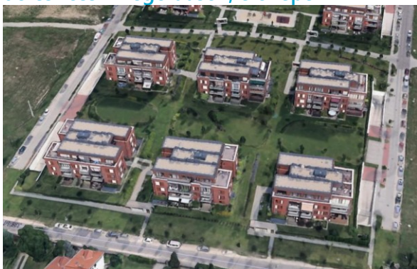
Sasad Resort lakópark, 4 szintes beépítés
