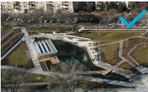
A 2022-ben átadott Vizafogó park mesterséges tava (~800 m 2 felületű, 1,5 m mély víztest)- a párolgási veszteséget részben a szomszédos épületről összegyűjtött csapadékvízzel pótolják. ( https://www.budapest13.hu/2022/03/08/atadtuk-a-vizafogo-parkot/ )
