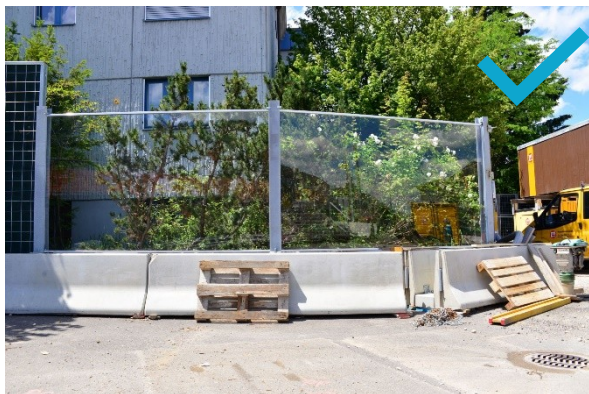
Építési terület elhatárolása hanggátló kerítéssel ( https://www.acryline.ch/EN/noise-barrier/ )
