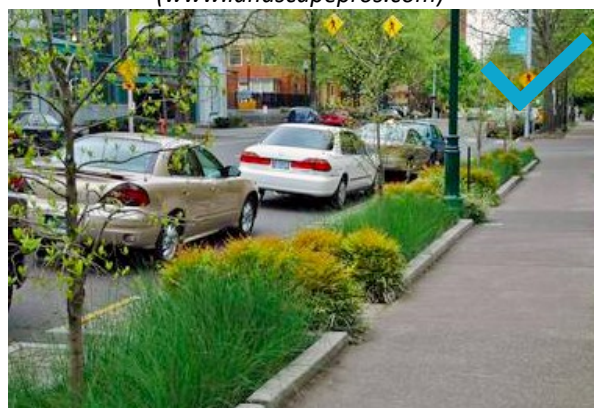
Green Streets, Portland Vízérzékeny kialakítású útszakaszok Kisebb alapterületű esőkertek, melyek a burkolatokról elvezetett csapadékvízét gyűjtik össze ( https://hpi-green.com/2009/11/25/portlands-green-streets/ )
