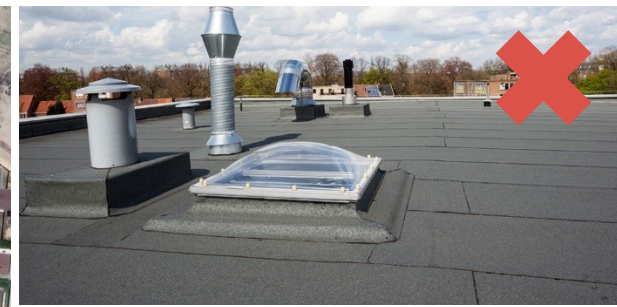
Sötét tetőfelület ( https://www.hustadcompany.com/pros-cons-flat-roofs/ )
