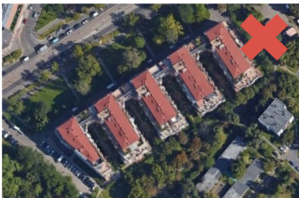
Lakóépület kedvezőtlen légtérarányú, három oldalról zárt udvarterei
