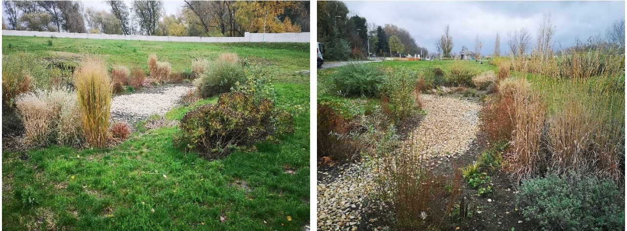
14. ábra Csapadékvíz elszivárogtató medencék Pünkösdfürdőnél
