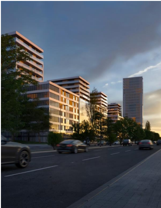
Budafoki úti épületsáv
