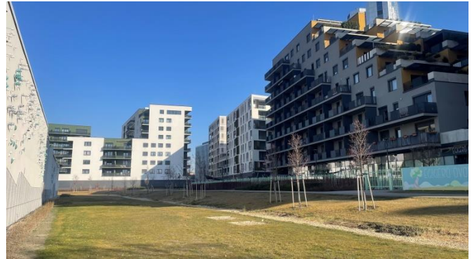
Épületállomány a Budapest fejlesztésnél a Dunapart felől
