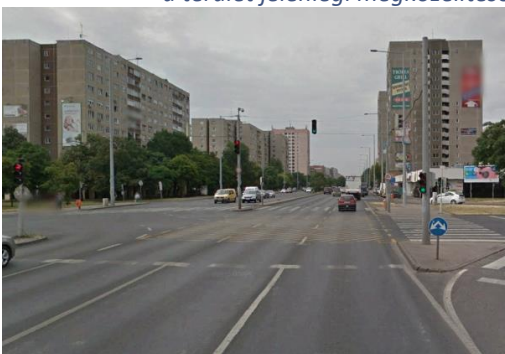
Átépített Bogdáni úti csomópont az Árpád híd irányába forrás: Google Streetview
