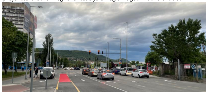
Felbővített Bogdáni úti csomópont nyugati irányba, a Hármashegy felé tekintve forrás: saját fotó
