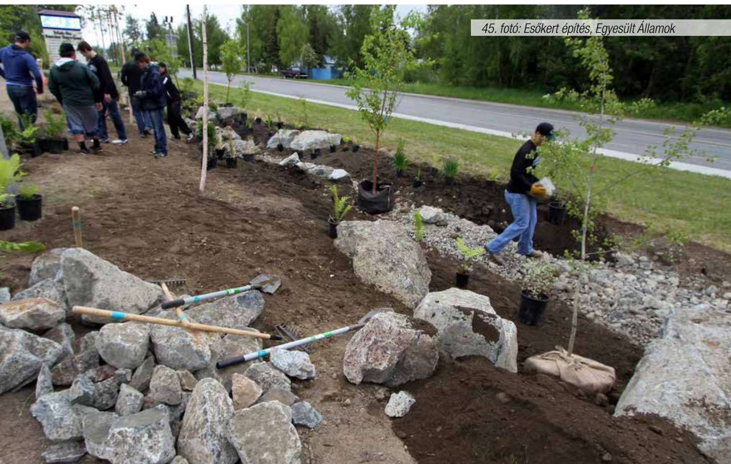
44. fotó: Új telepítésű esőkert túlfolyókkal, Egyesült Államok
