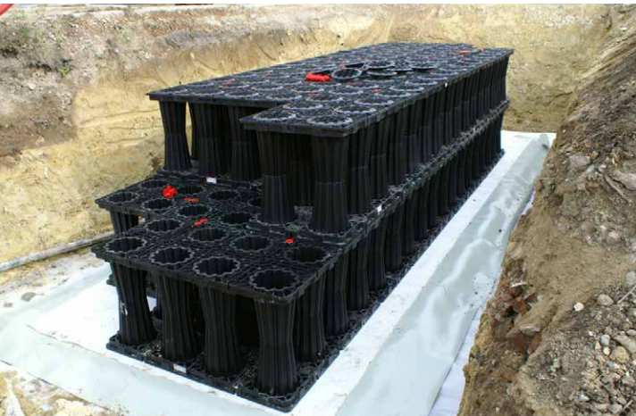
48. fotó: Szikkasztóládás csapadékvíz szikkasztás
