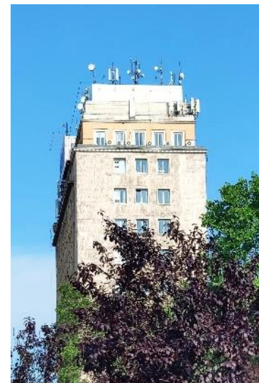
Mikrohullámú antennák tetőszerkezetén
