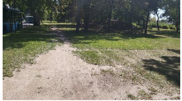
4) Áttaposás vagy nagy arányú javítás, teljes átépítés szükséges. Összesen: 17 842 m 2
