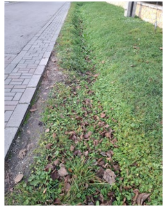
17. ábra: Gyepborítású szikkasztóárok, illetve gyephézagos burkolattal ellátott elvezető árok (forrás: szerzői fotó)
