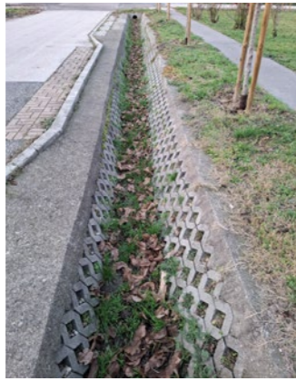
17. ábra: Gyepborítású szikkasztóárok, illetve gyephézagos burkolattal ellátott elvezető árok (forrás: szerzői fotó)
