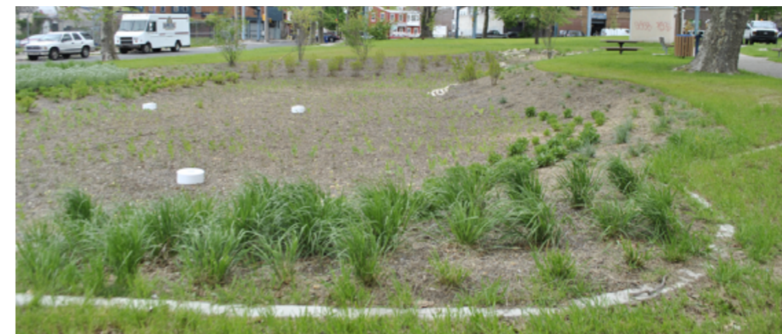
39. fotó Új telepítésű esőkert túlfolyókkal, Egyesült Államok
