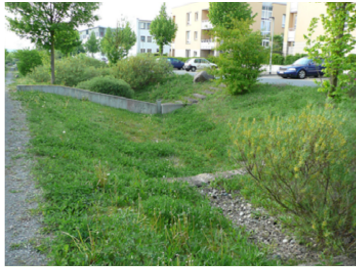
43. fotó Többszintes drénezett szikkasztóárok
