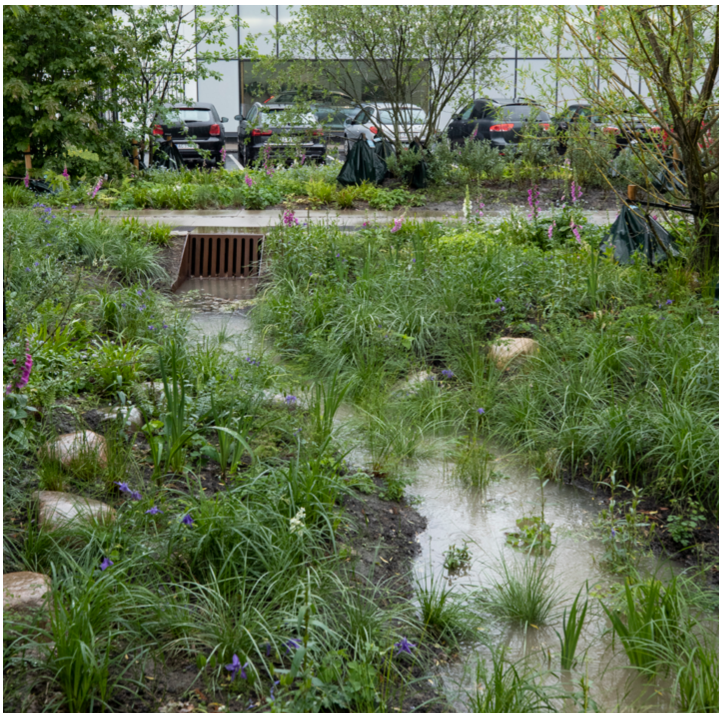
51. fotó A szikkasztó árkok hálózata és az út mentén kialakított „mini wetland”-ek a legintenzívebb felhőszakadásokat is kezelik
