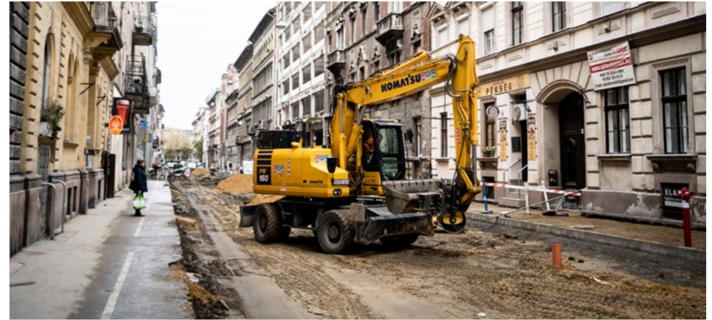
76. fotó Kivitelezés közben – a faltól-falig megújítás következtében az utcában lehetőség nyílt új zöldfelületek kialakítására, melyek tagolják a parkolósávokat
