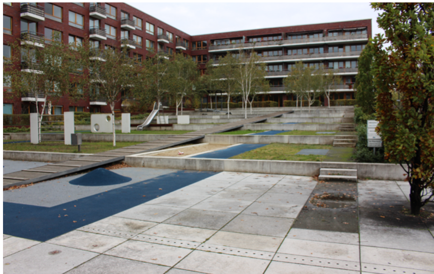
68. fotó Többszintes zöldfelület és játszótér vízáteresztő burkolattal. Az enyhén visszafelé lejtő teraszok tárolják és szikkasztják a csapadékot.
