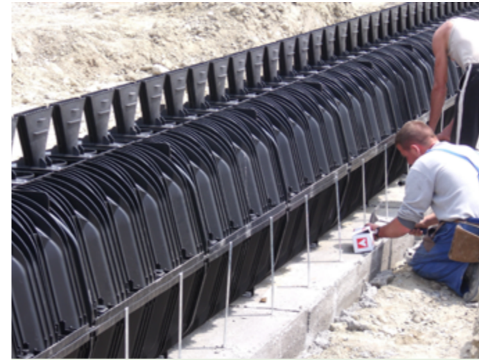
42. fotó Nagy tározókapacitású részfolyóka beépítése
