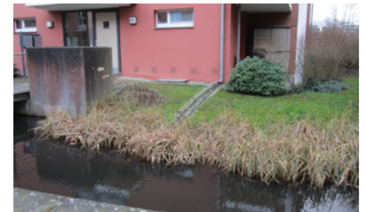
61. fotó A víz a vápákon keresztül a fő csatornába kerül
