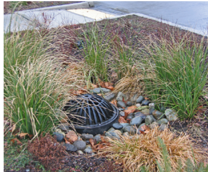
36. fotó Túlfolyó kialakítása
