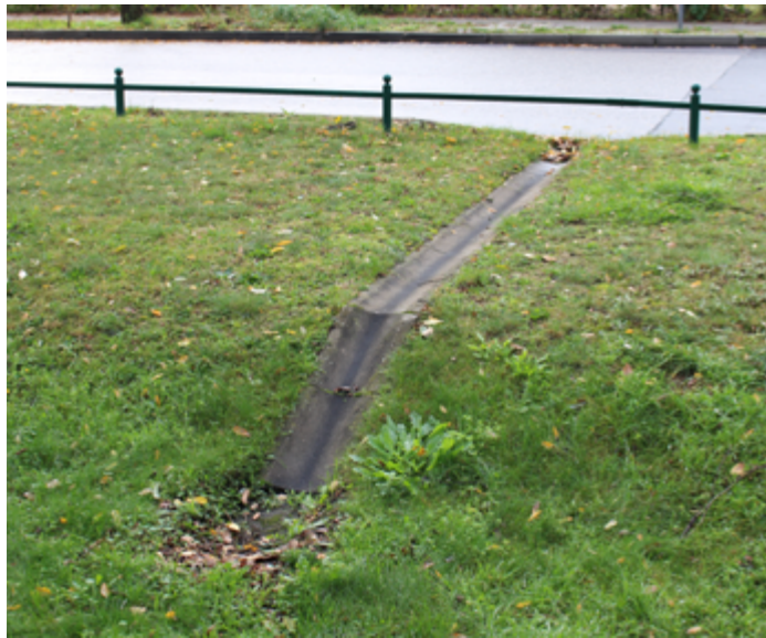
35. fotó Beömlő vápa kialakítása alacsony lejtés esetén
