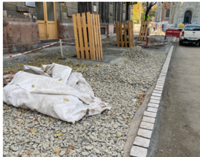
73. fotó Bakáts utca: 60 cm SFR szerkezeti talajjal és 20 cm drain réteggel visszatöltött gyökérzóna, amely már tömöríthető, stabil alépítmény a járda és az úttest számára
