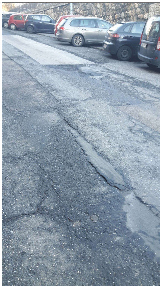
3.1.4 ábra: A felújításra tervezett Bp. II., Rómer Flóris utca egy részlete
