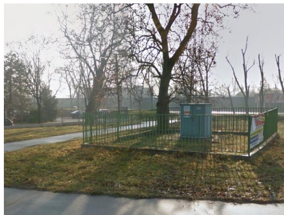
Lemezház nagyközép/növelt kisnyomású gáznyomásszabályzó a Városhal utca mellett (forrás: maps.google.com)
