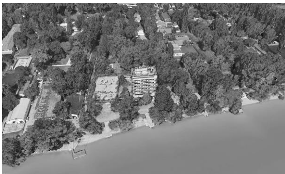
A régi Postás üdülő felújítás előtt
