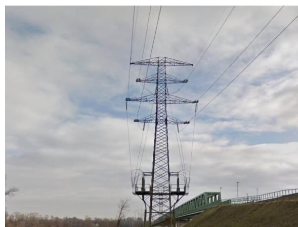
ELMŰ 120 kV-os légvezetékes hálózat rácsos tartóoszlopa a Pók utcánál (forrás: maps.google.com)
