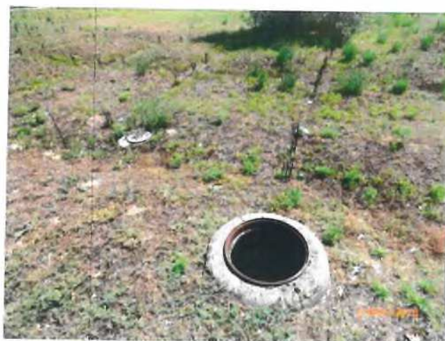
az ingatlan, az elkezdett csatorna kiépítés
