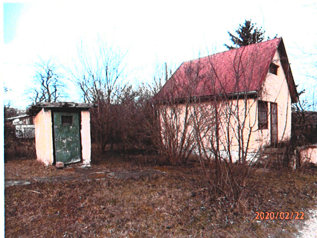
Az értékelt gazdasági épület nyugati homlokzata
