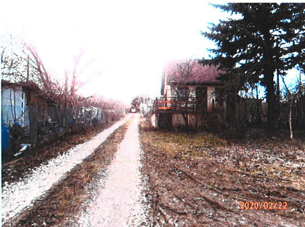
A telekrész és a gazdasági épület keleti homlokzata
