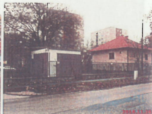
telek körüli épületek
