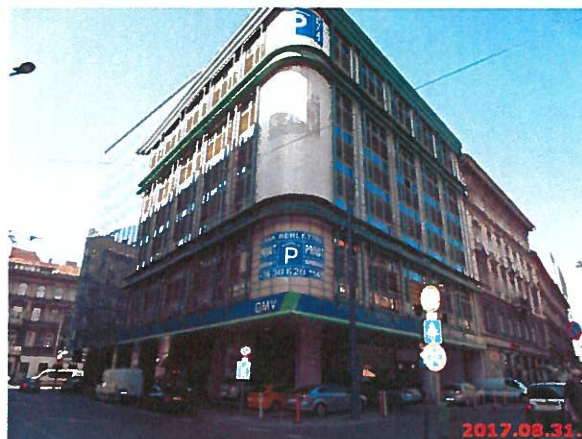
Szabó Ervin tér felőli homlokzat
