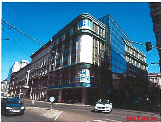
Üllői út felőli homlokzat
