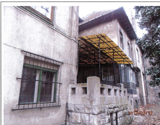
Oldalkert felőli, délnyugati homlokzat
