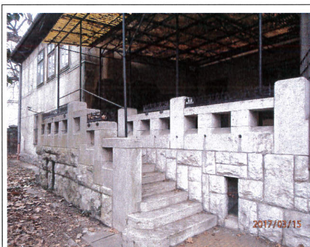
Délnyugati homlokzat, oldalkert felőli terasz
