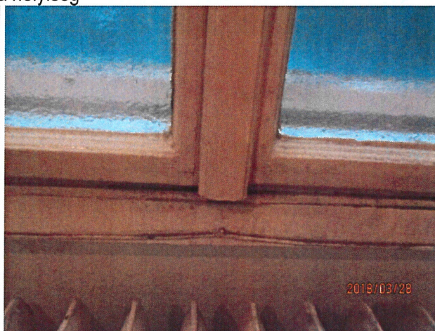
Első iroda helyiség, beázás nyomai, mennyezeten keresztül és az ablak alatt
