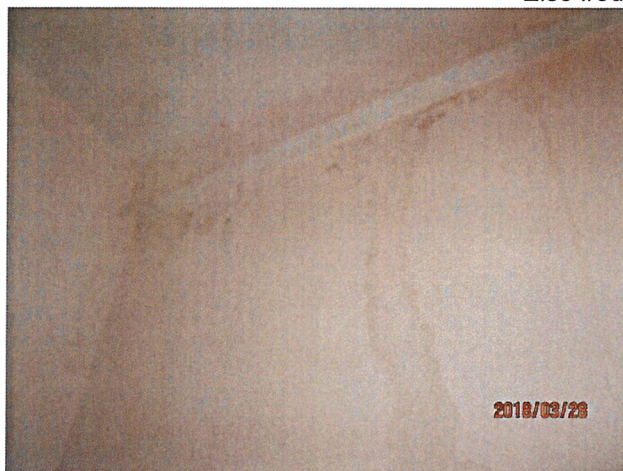
Első iroda helyiség, beázás nyomai, mennyezeten keresztül és az ablak alatt
