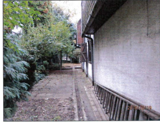
A telek képe és a ráépített épület az utca felé tekintve
