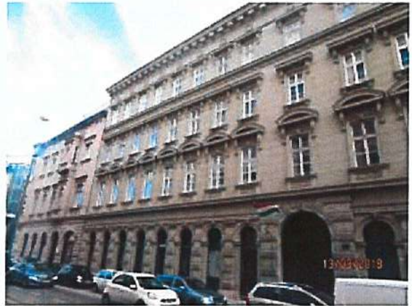
Az épület homlokzata
