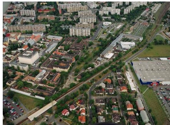
Az Aquincumi híd leendő pesti hídfője
