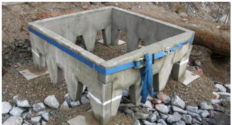
71. fotó: A stockholmi betonszegély kivitelezés közben
