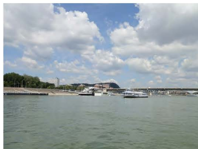
Petőfi-híd, budai hídfő
