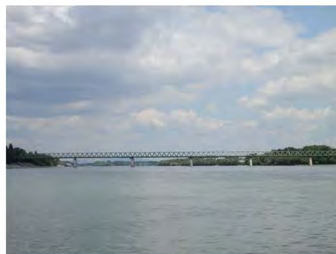
Északi-összekötő vasúti híd
