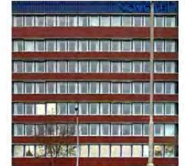
Horizontális tagolású homlokzat
