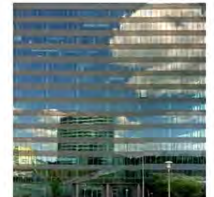
Üvegezett függönyfal homlokzat
