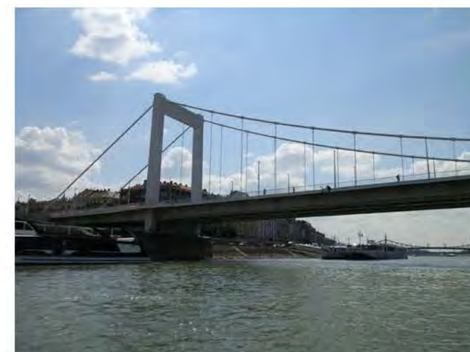
Erzsébet-híd, pesti hídfő
