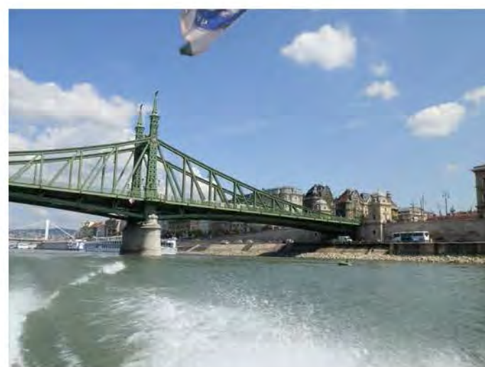
Szabadság-híd, pesti hídfő
