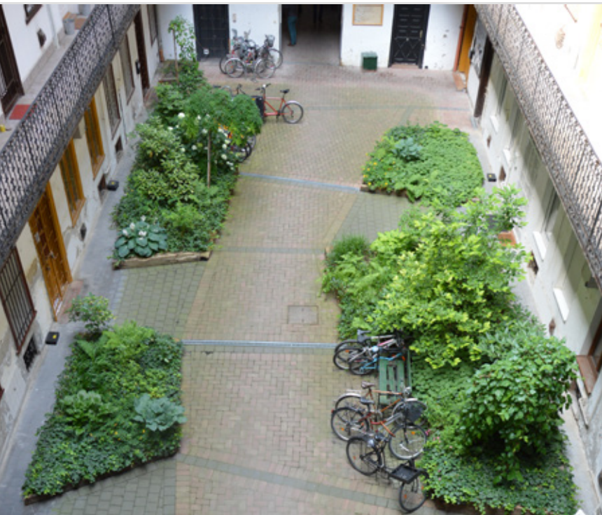
73. fotó: Gyulai Pál utcai társasház udvara a felújítás után
