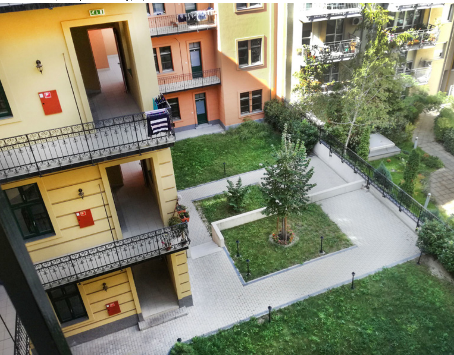
7. fotó: Épületszárny bontása révén megújult épületek Ferencvárosban
