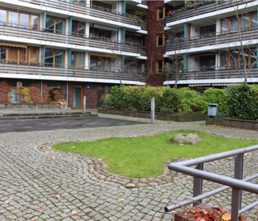
40. fotó: Vízáteresztő burkolat belső udvarban, Berlin
