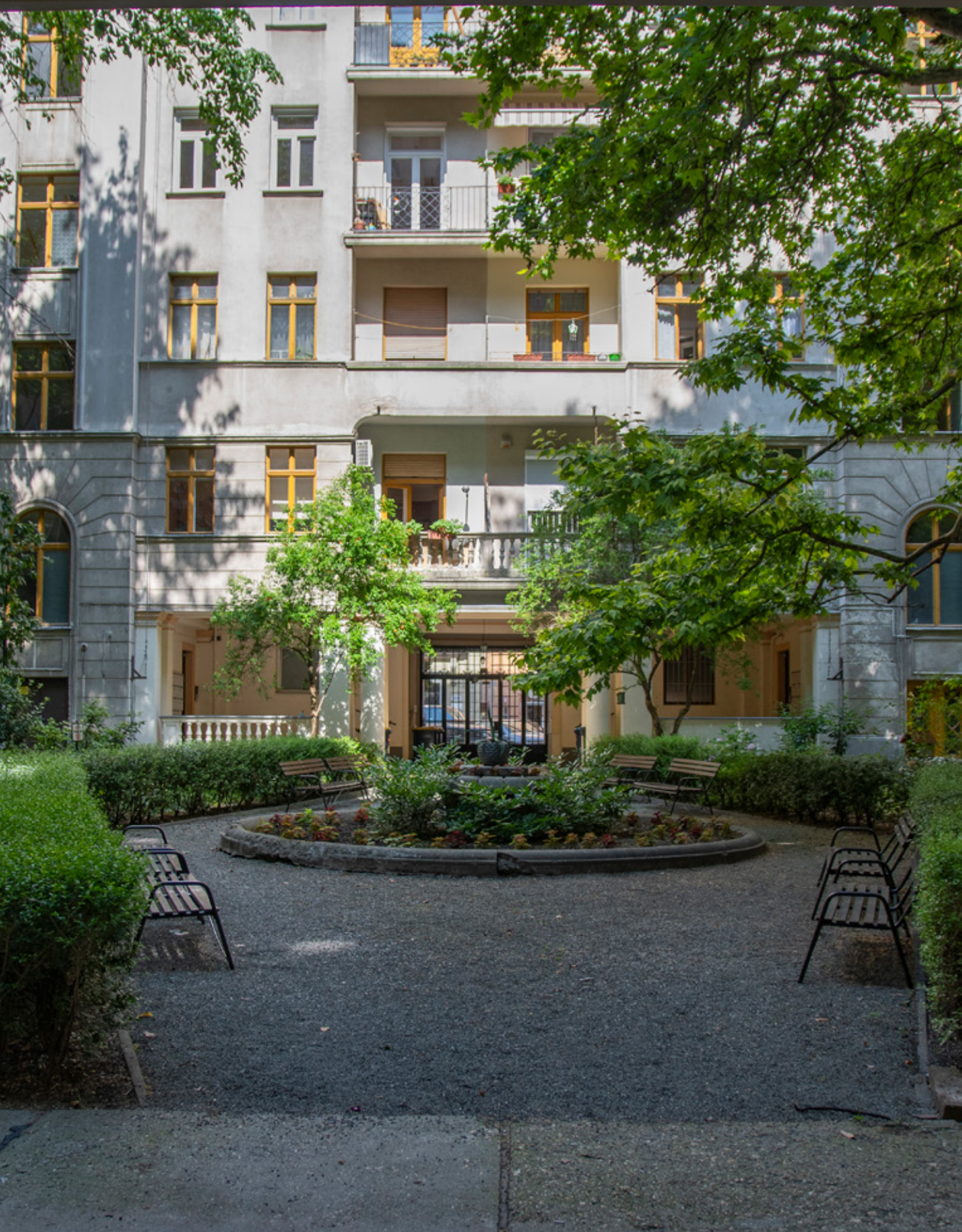
90. fotó: Árnyas udvarkert padokkal
